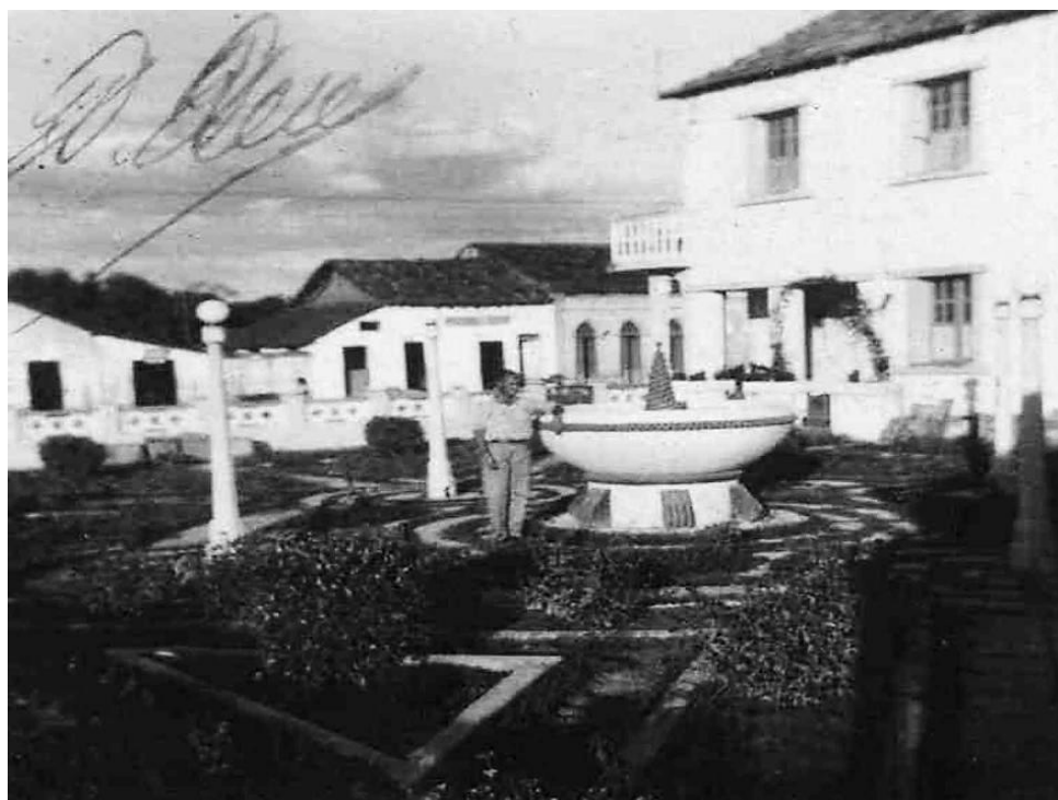
Foto do Jardim e do Chafariz da Residência do Governador concluídos – em 1940. Ao fundo edificações da época na avenida Jaime Brasil. Fonte: Acervo de Darcy Romero Derenusson.
