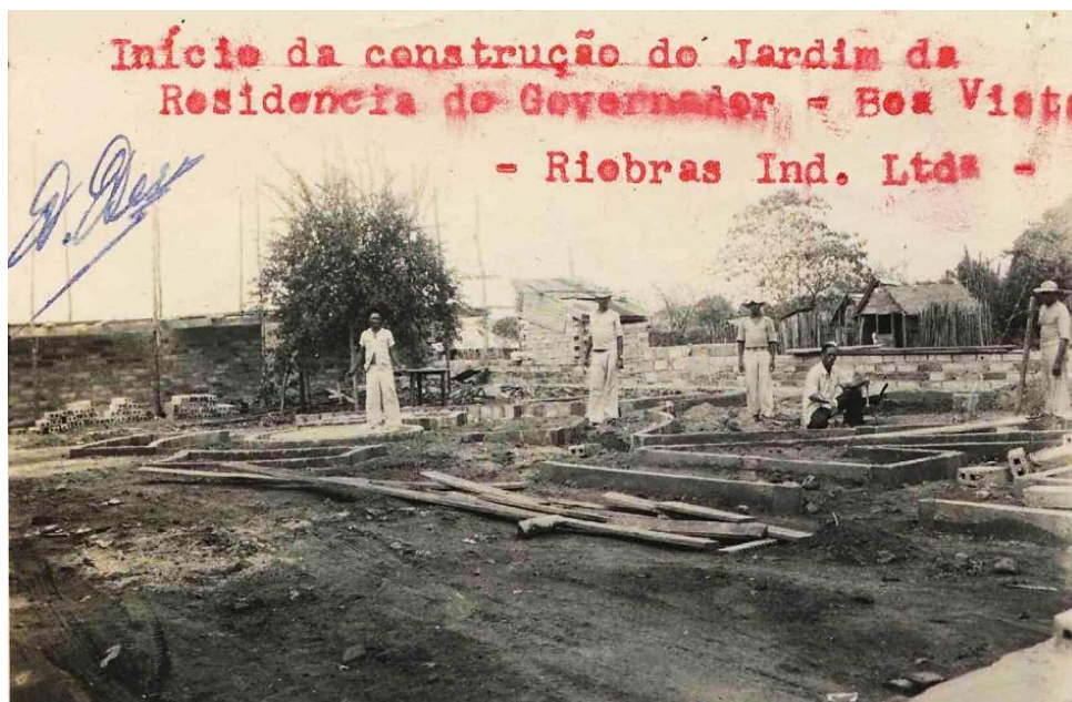
Legenda - Foto da construção do jardim e do chafariz na parte da frente do terreno da residência do governador na década de 1940. Fonte: Acervo de Darcy Romero Derenusson.
