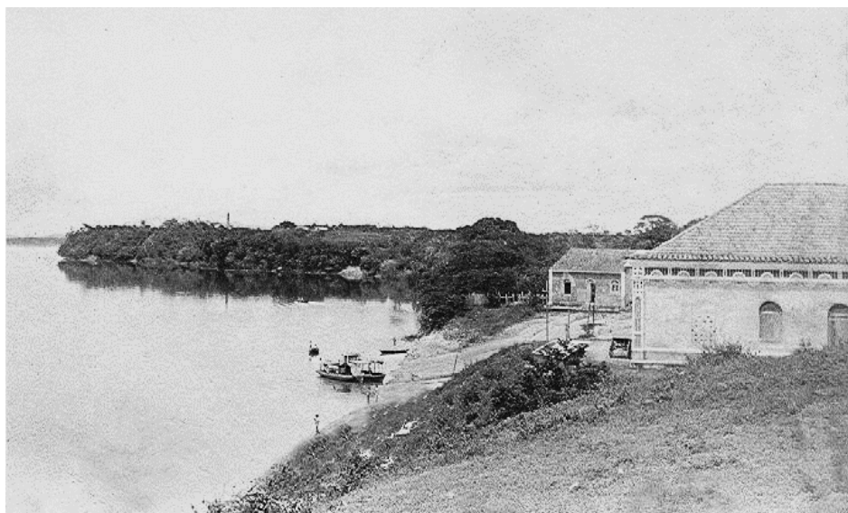
Legenda da Imagem: Vista do Porto de Cimento e do prédio original da Intendência, orla do Rio Branco, na Vila de Boa Vista, na década de 1920. Construída ao nível do cais, a Intendência vivia sob ameaça de cheias sazonais do rio Branco
