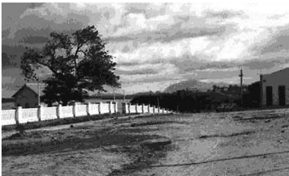
Legenda: Foto da Avenida Floriano Peixoto – balastrada com o muro do mercado em toda a extensão da calçada. Foto de 1948. Fonte: Acervo de Darcy Romero Derenusson
