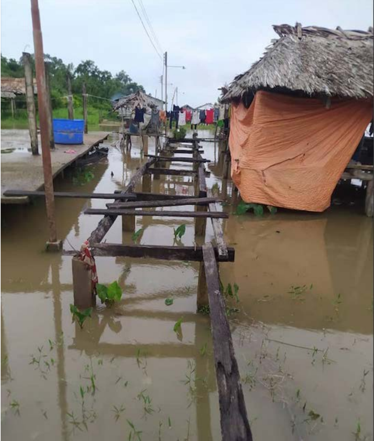
Figura 9: Caminerías destruidas y en algunas casas, ancianos esperando la muerte. Delta del Orinoco.
